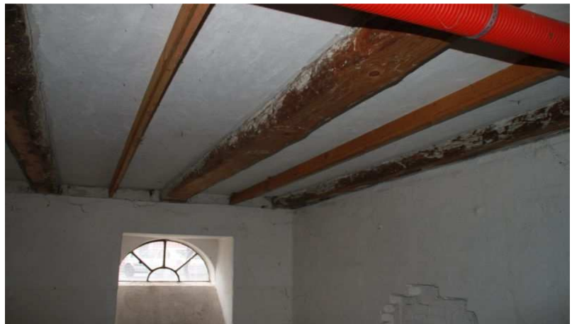
Delvist blotlagte etagebjælker i kælder.
