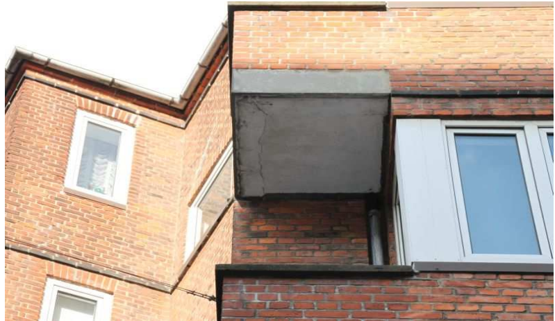
Altanbund og murværk v. altan/karnap Kurlansgade 28 – Inden renovering
